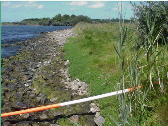
Foto 3. Transect steile oever van de Mosselplaat
