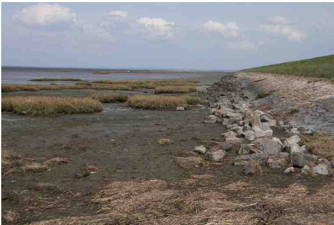
Foto 31: Proefstrook 27 slik met een smalle strakke kreukelberm en geen stenen op het slik
