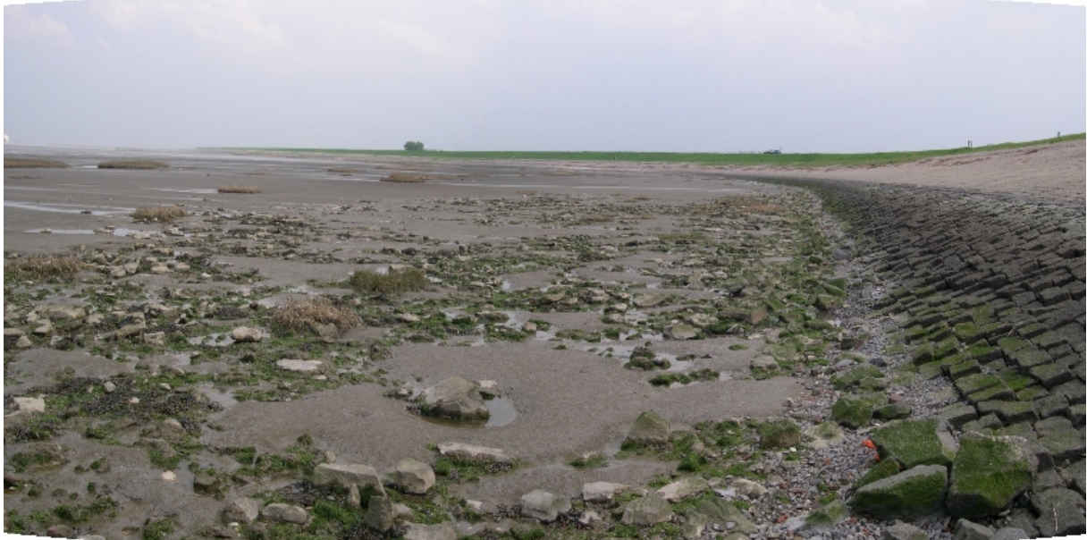
Foto 6: Proefstrook 5, breed uitgewaaierde (15 meter) kreukelberm op het slik
