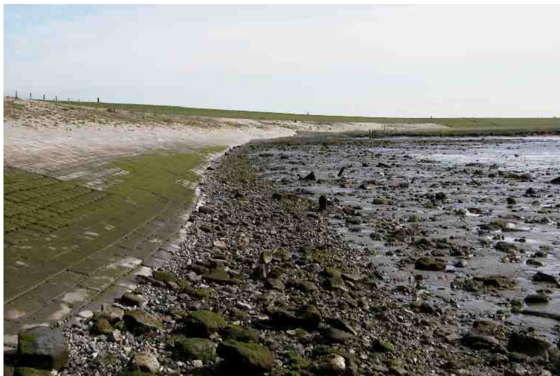
Foto 22: Proefstrook 19, smalle werkstrook van 2 meter waarmee een geul is gespaard, helaas is de werkstrook niet weer afgedekt met de uitgegraven grond, onduidelijk is waar deze grond gebleven is.
