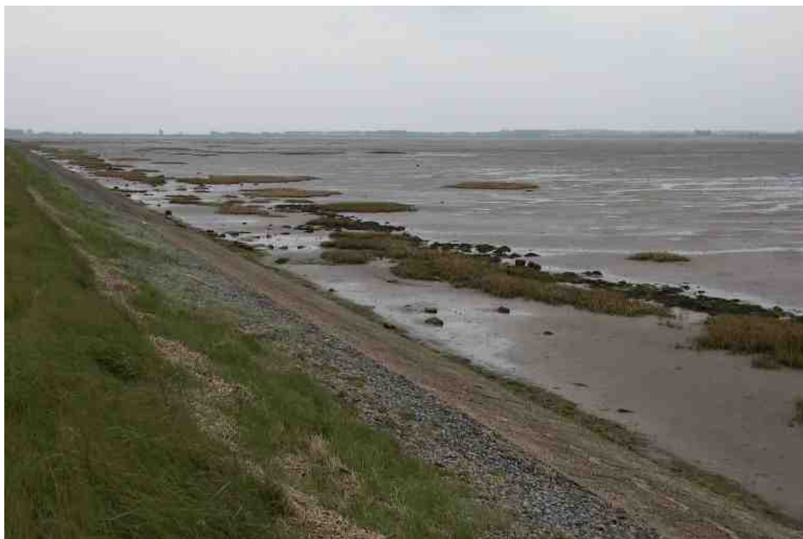
Foto 34: Proefstrook 31 op 8 meter uit de teen van de dijk een duidelijke strook met stenen, waarschijnlijk als gevolg van het vergraven van de werkstrook.
