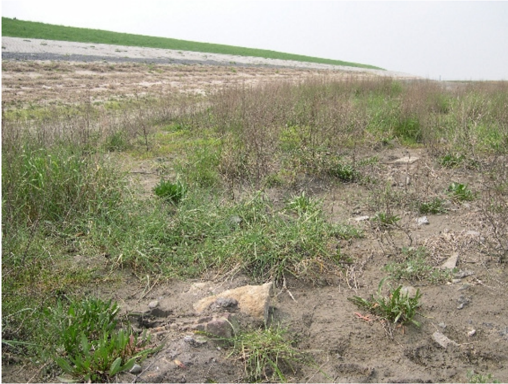
Foto 4: Proefstrook 4 Hellegatpolder, stenen aan de oppervlak in werkstrook. Werkstrook hobbelig afgewerkt.
