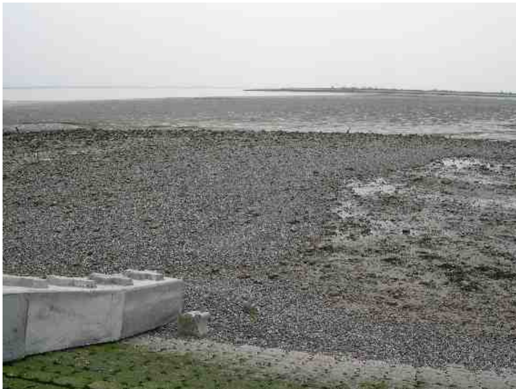
Foto 19: Proefstrook 15 (foto) en 17, restanten van depot op slik, \pm 0,5 ha. Slik is bedolven onder stenen
