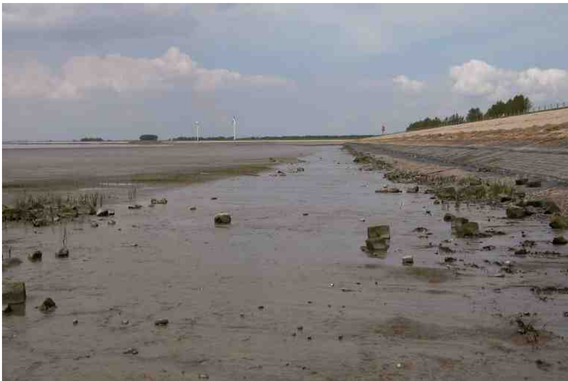
Foto 29: Proefstrook 26, een duidelijk nattere baan loopt parallel aan de dijk, dit lijkt een effect van de werkstrook te zijn maar kan ook veroorzaakt worden door uittredend water aan de voet van de dijk. Op luchtfoto's van voor de verbetering is ook een dergelijke strook te onderscheiden.
