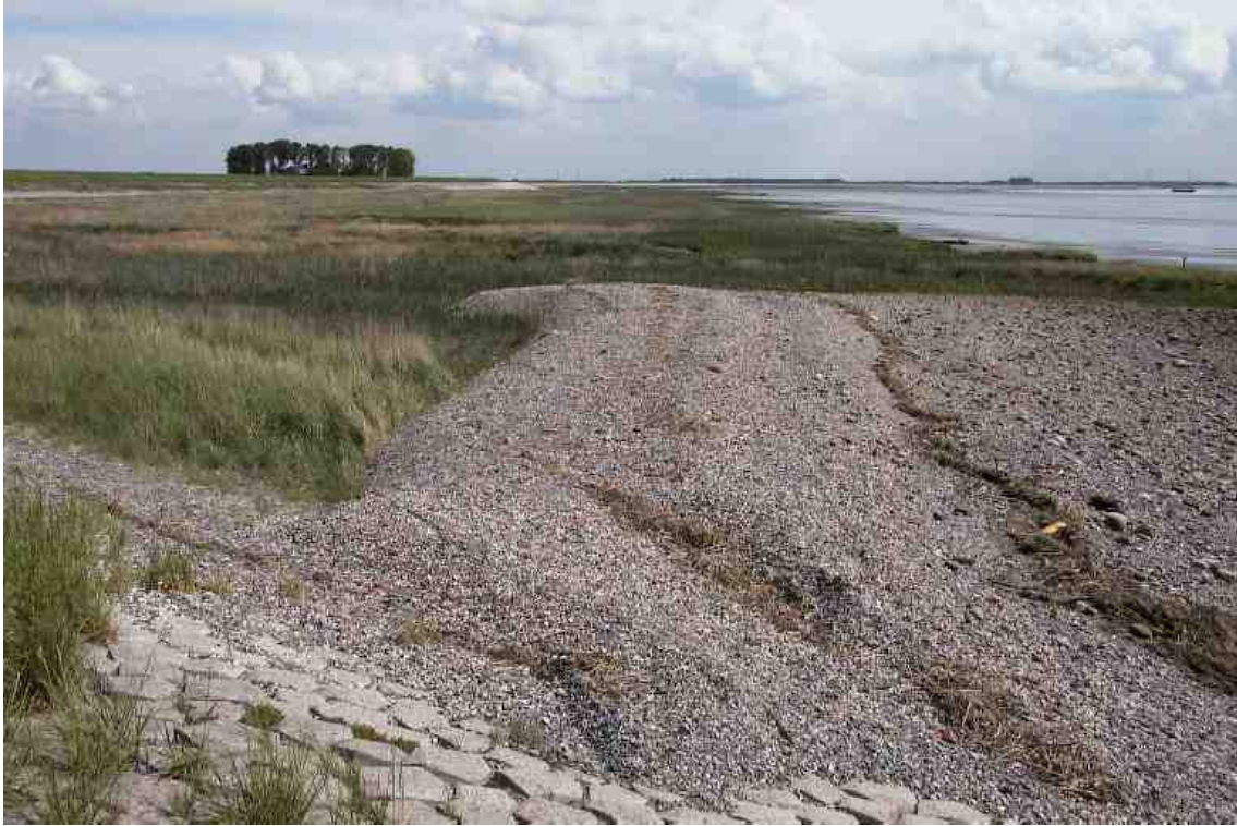
Foto 26: Proefstrook 24, steenslag waarmee de dijk is afgestrooid spoelt van de dijk en verzamelt zich hier op het schor als een soort van strandhaak.
