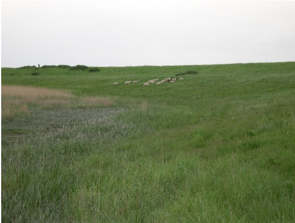
Foto 40: Proefstrook 35 een mooie vloeiende overgang van schor naar dijk geen werkstrook zichtbaar
