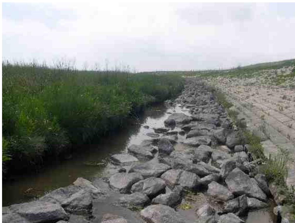
Foto 22: Proefstrook 19, smalle werkstrook van 2 meter waarmee een geul is gespaard, helaas is de werkstrook niet weer afgedekt met de uitgegraven grond, onduidelijk is waar deze grond gebleven is.
