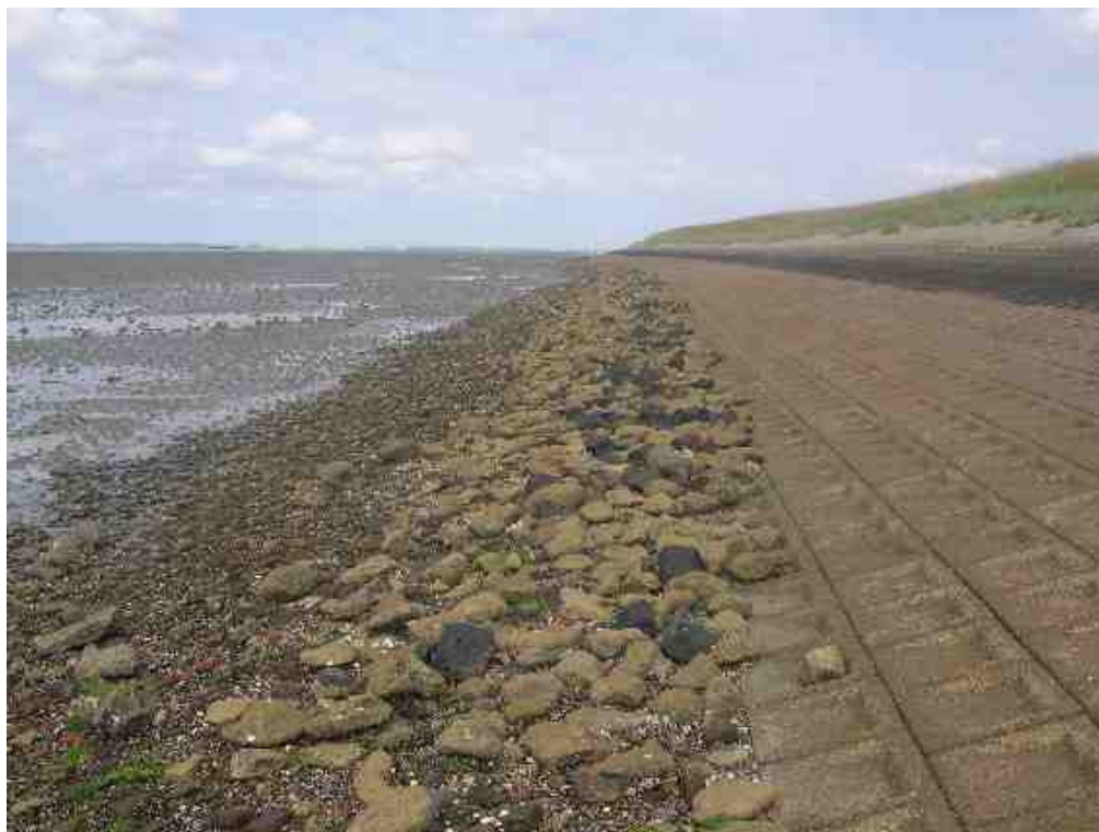
Foto 32: Proefstrook 36 het slik grenzend aan de dijk lijkt over een strook van 20 meter natter en er liggen hier en daar stenen op het slik. Kreukelberm netje binnen propties.
