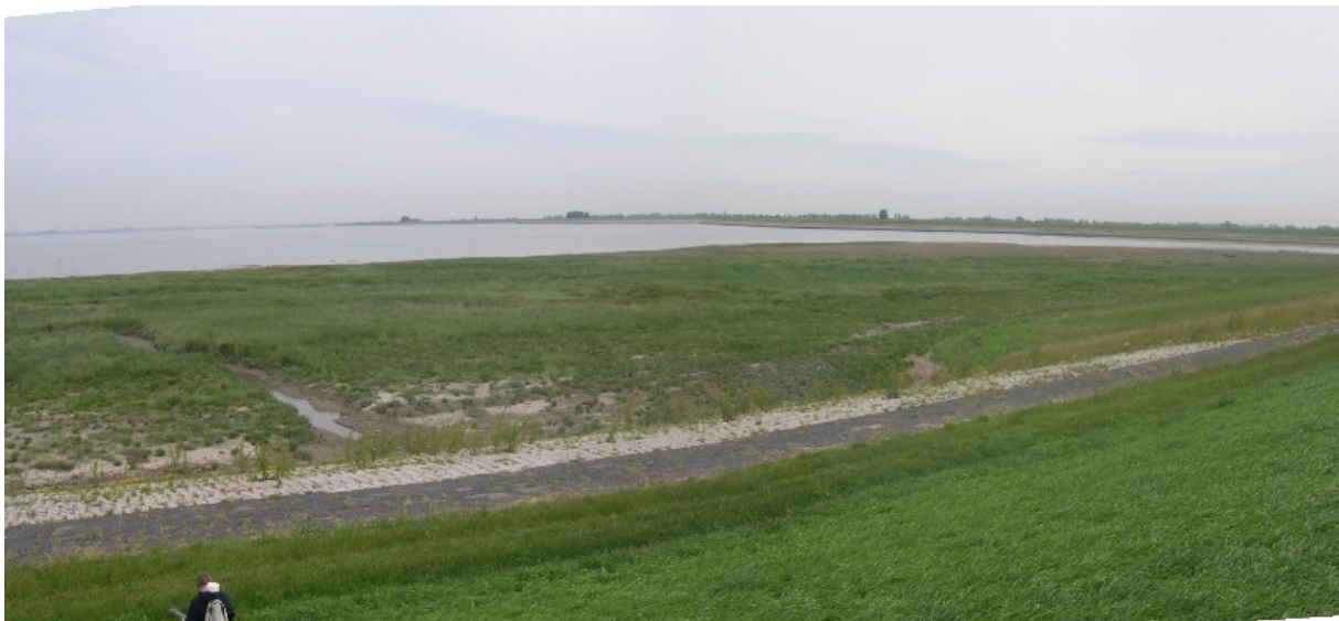
Foto 5: Overzicht proefstrook 3 (rechts) en 4 (links) Hellegatpolder, duidelijk is de brede werkstrook te herkennen in de vegetatie van het schor
