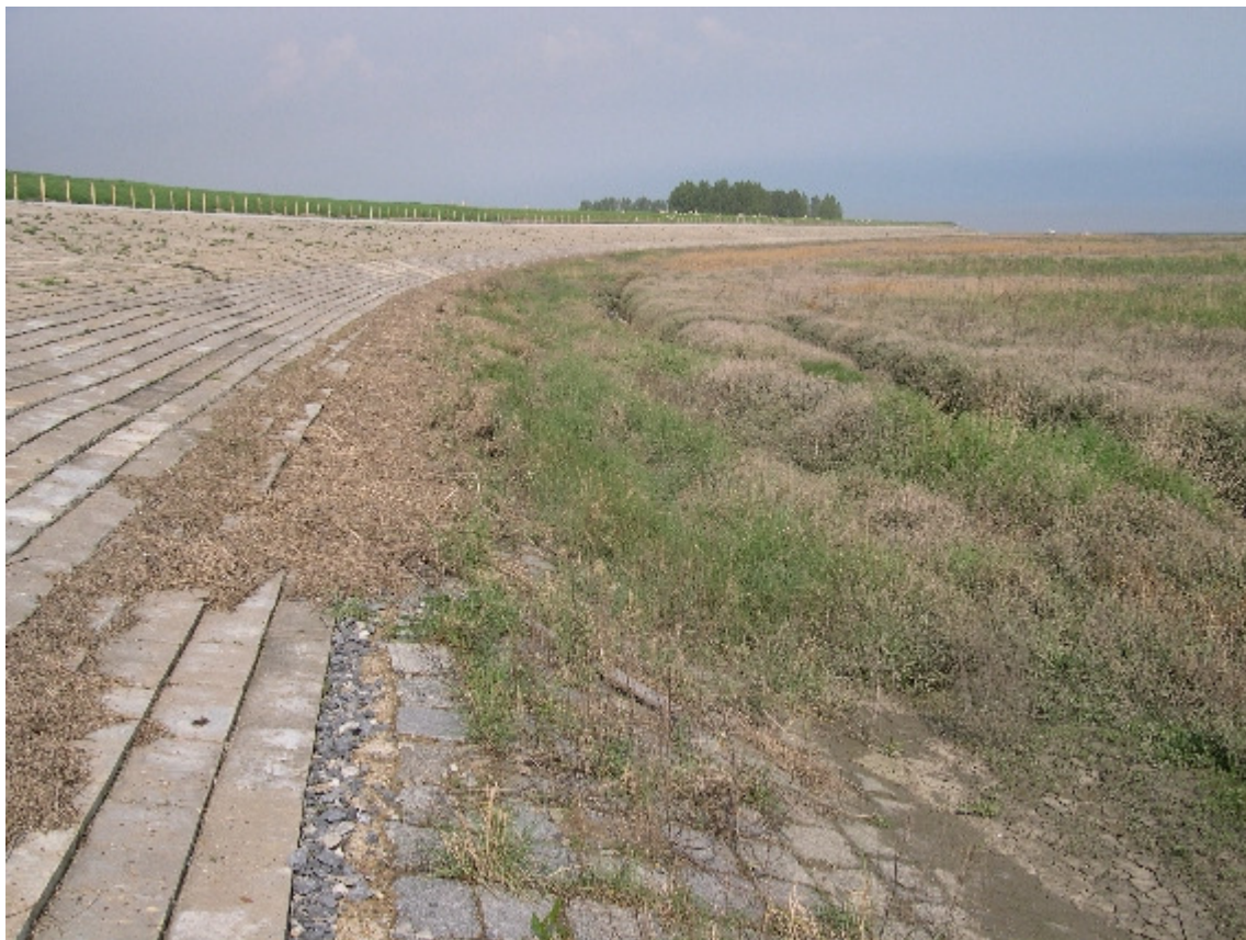
Foto 1: Proefstrook 1 Paulinapolder. De werkzaamheden zijn beperkt gebleven tot de boventafel, hierdoor is er geen werkstrook aanwezig op het schor.
