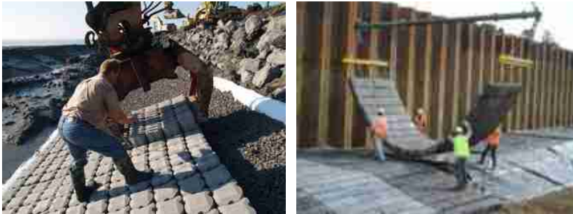
afbeelding I.3. Plaatsing gezette bekleding (links) en plaatsing blokkenmat (rechts)
