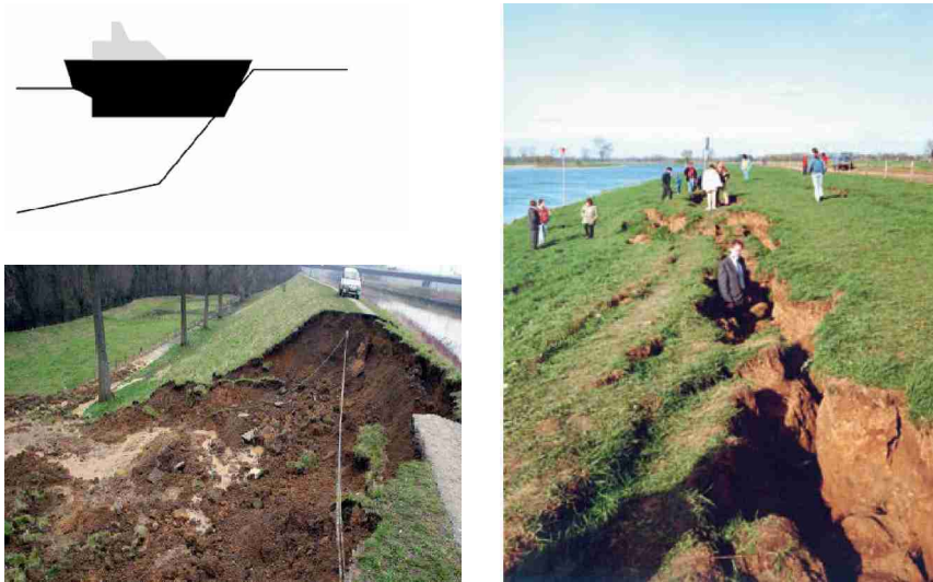
afbeelding 3.12. Aanvaring (links boven), kabels en leidingen (links onder) aardbeving (rechts)
