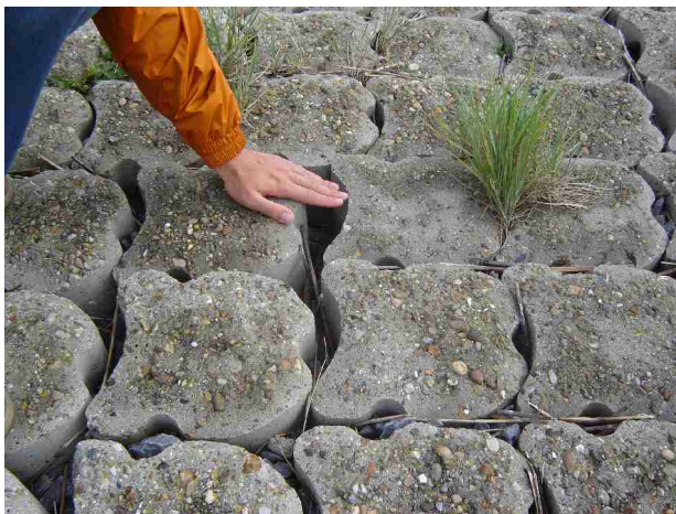
afbeelding 6.2. Slecht geplaatste zuilen (links) en blokken (rechts). Is dit binnen de toleranties?
