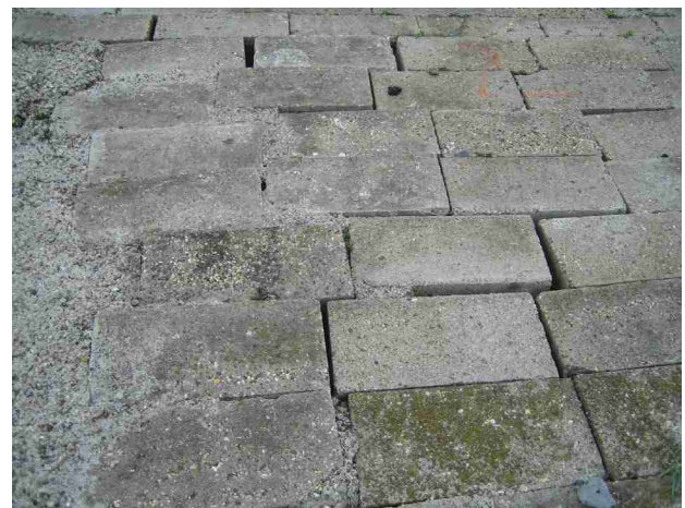
afbeelding 6.2. Slecht geplaatste zuilen (links) en blokken (rechts). Is dit binnen de toleranties?
