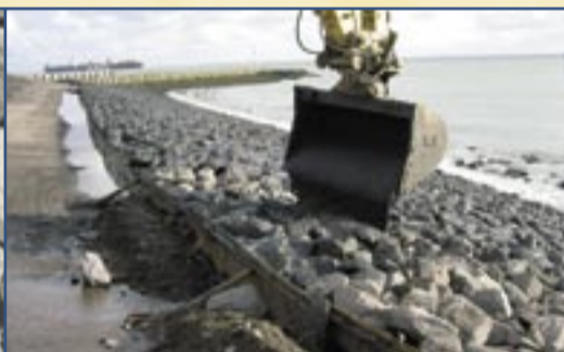
Breuksteen, ingegoten met gietasfalt
