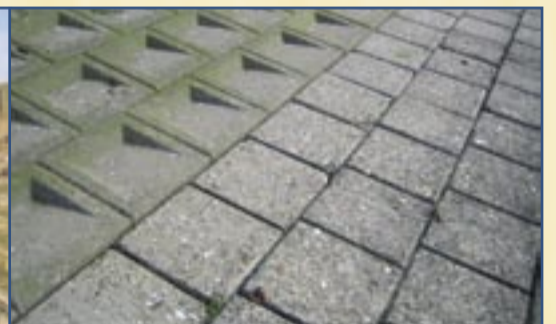
Haringman- (l) en betonblokken (r)
