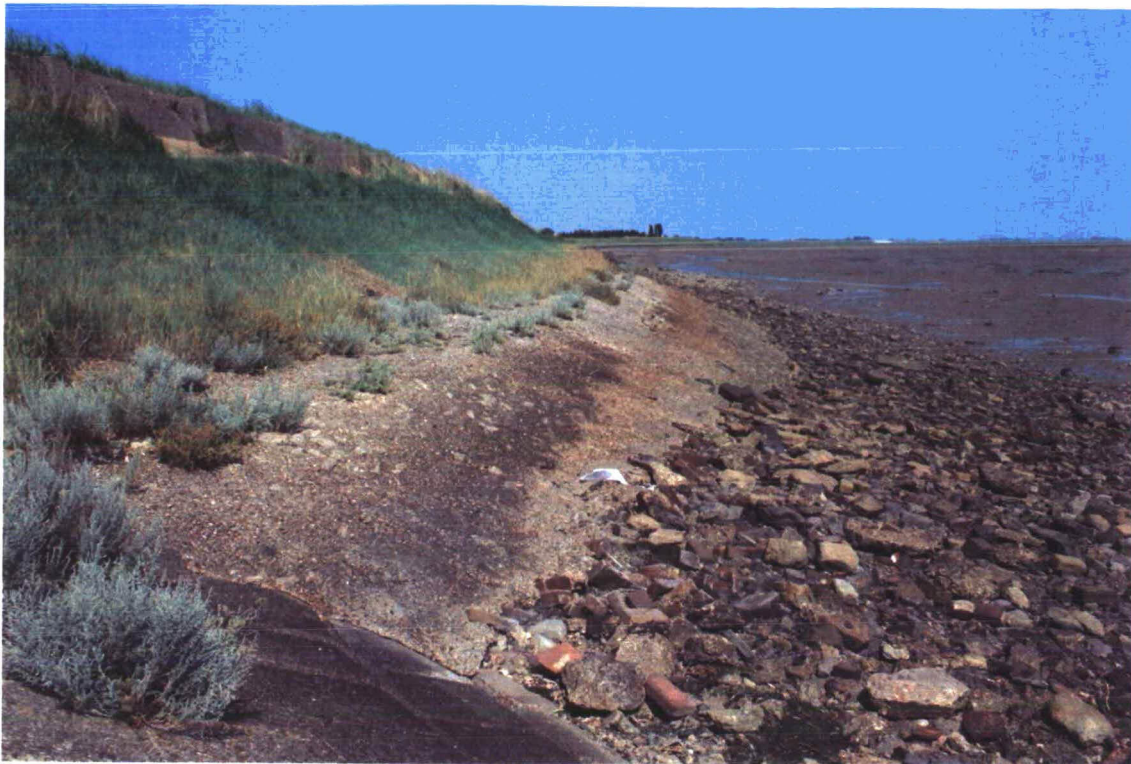
Foto 2.2 De dijk ter hoogte van deelgebied 1 bij laagwater. Een berm ontbreekt hier.
