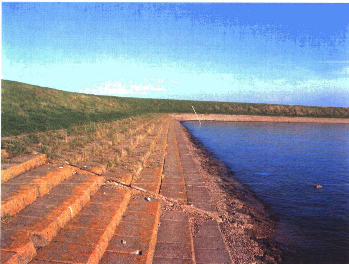
Foto 1.2 Huidige dijkbekleding in deelgebied 5.
