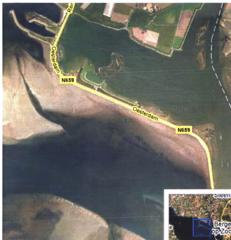
Figuur 4: Luchtfoto traject Oesterdam-Noord dp 1080 – dp 1150 (bron: www.maps.google.nl )
