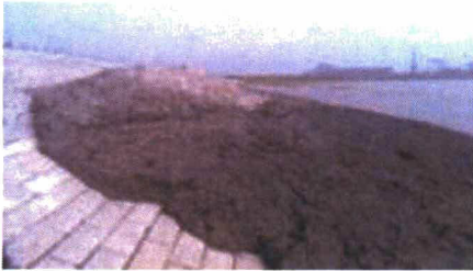
Zand omgeven door klei t.b.v. schorzijdebij
