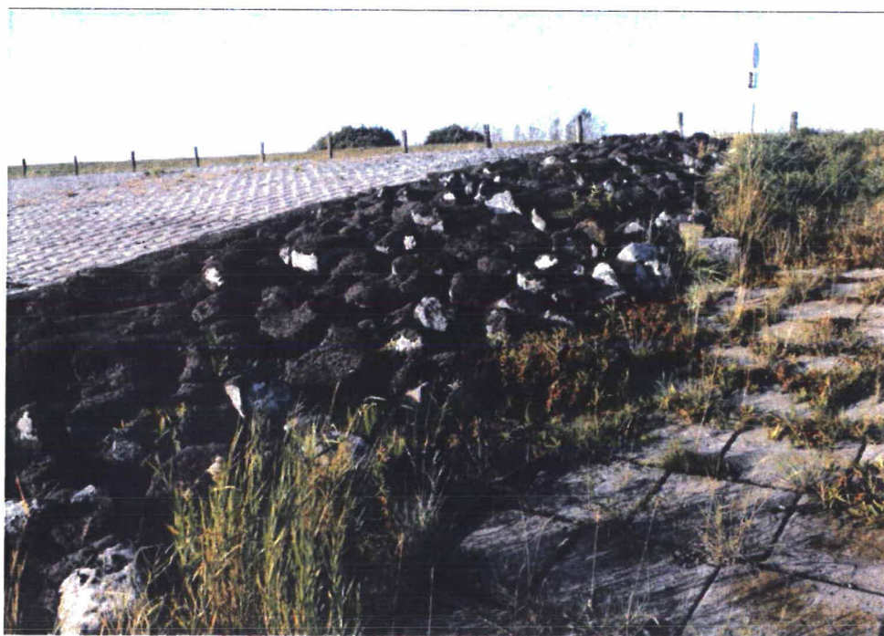
Figuur 2.3 Overgang van reeds voltooide dijktraject Westelijke Sloehavendam (links op de foto) naar het te realiseren Schorerpolderdijk dijktraject.
