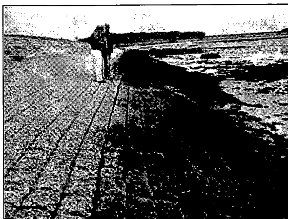
Foto's 1 en 2: vervorming in glooiing (dijkpaal 344+50m)
