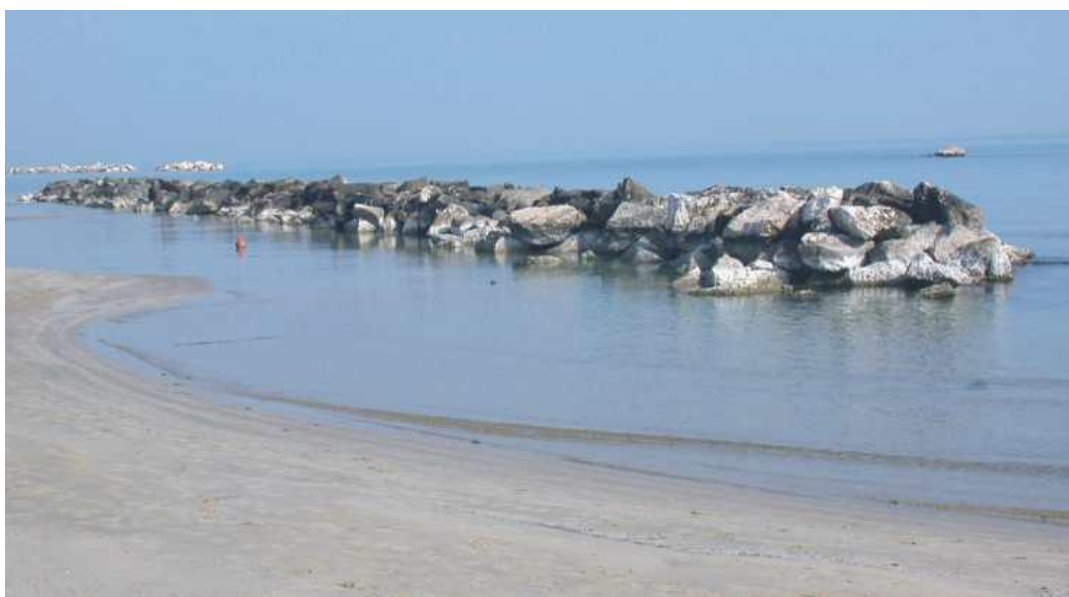
Figure 2.14 - Example of barrier with natural boulders (Agenzia nazionale per la protezione dell' ambiente 2007)
