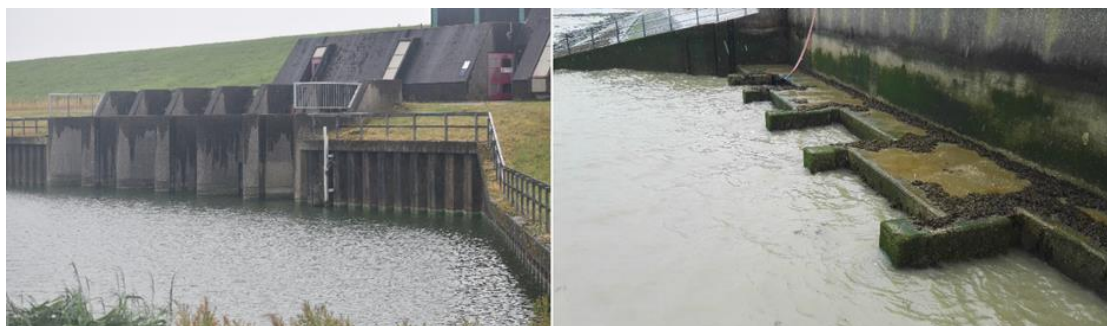
Figuur 2.4: Aanzichten van respectievelijk de noordzijde (Bathse Spuikanaal, zoet water, links) en de zuidzijde (Westerschelde bij opkomend tij, zout water, rechts) van Bathse Spuisluis.
