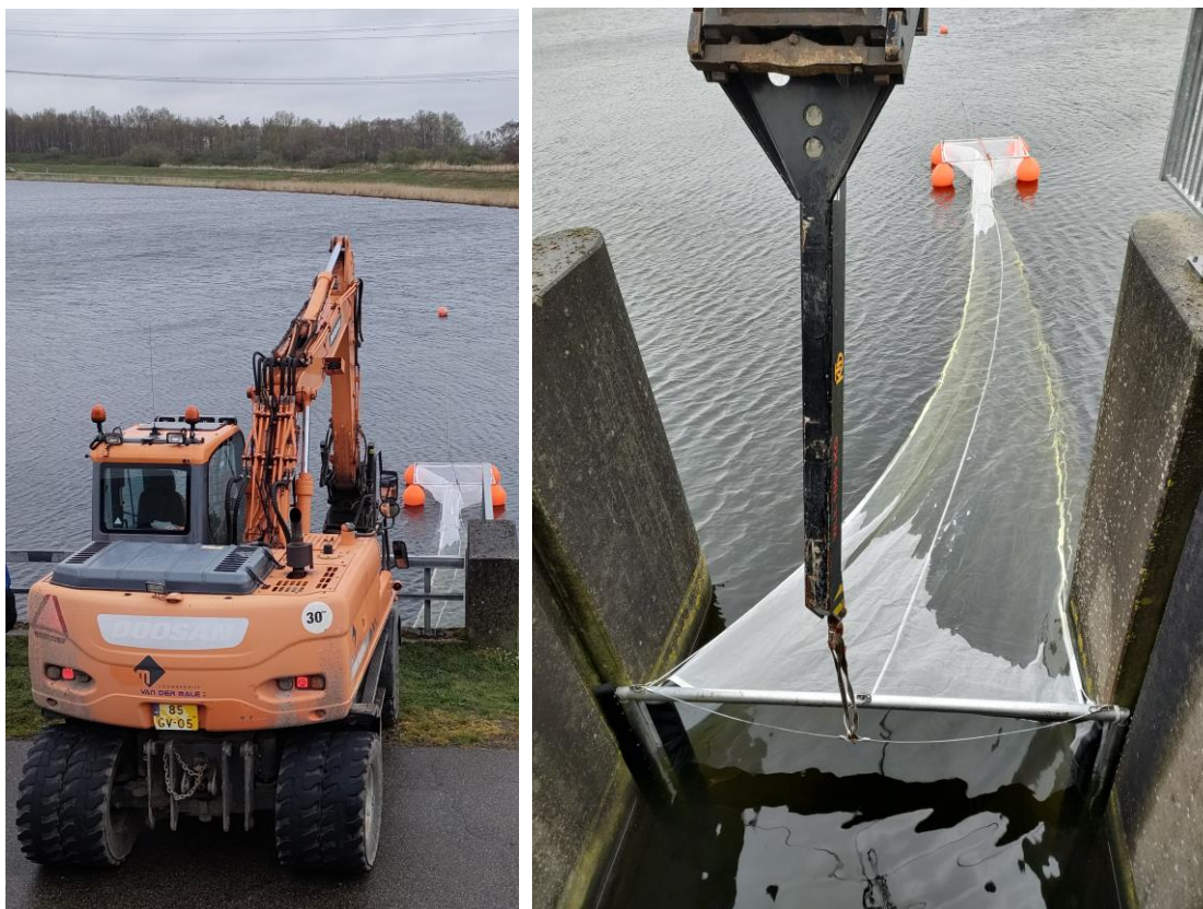
Figuur 2.9: Het specifiek voor deze locatie ontworpen opvangnet met aan het einde een Noors leefnet wordt met behulp van een kraan aan de achterzijde van de spuikoker met vismigratievoorziening geplaatst (Foto's: Jisk van den Ende).
