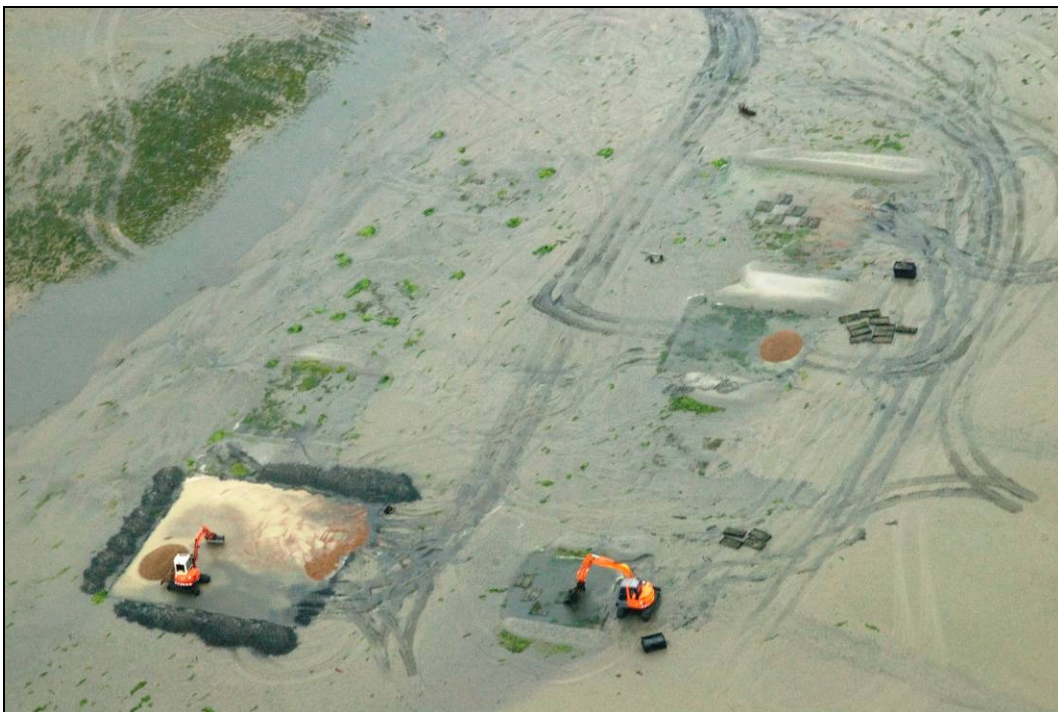
Foto 9 Luchtfoto van werkzaamheden op de Dortsman Noord
