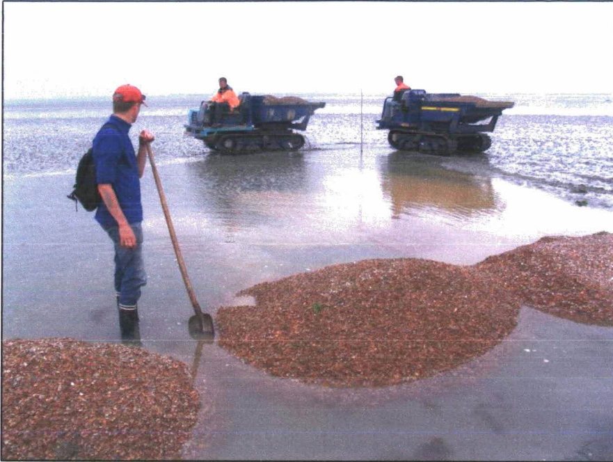
Figuur 9 Schelpenbehandeling van een plot
