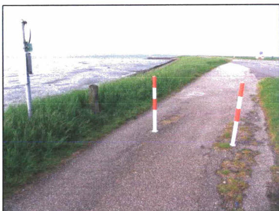
Foto 5: begin van het fietspad (punt 6)
