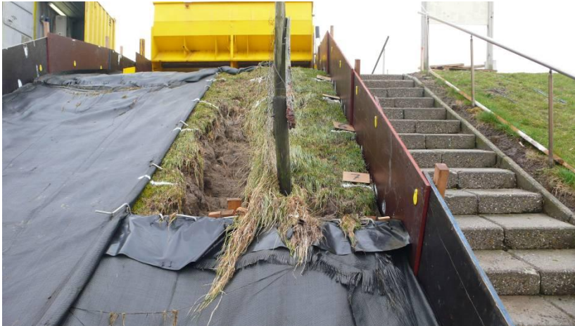
Foto 3.29 Erosie toplaag
