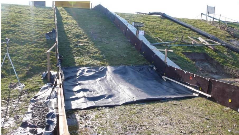
Foto 3.39 Afdekking teen talud
