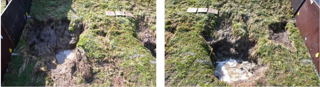
Foto 3.36 Het ontstaan van gaten direct na de teen
