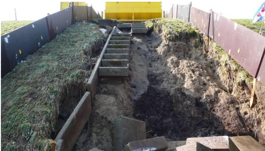
Foto 3.16 Eindresultaat proef 10 l/s per m boven en halverwege het talud
