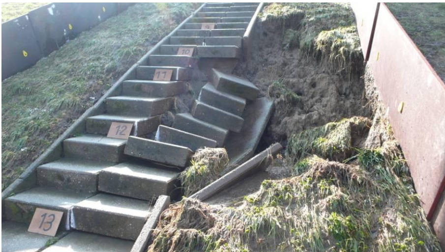
Foto 3.11 Instorten van de treden van de trap
