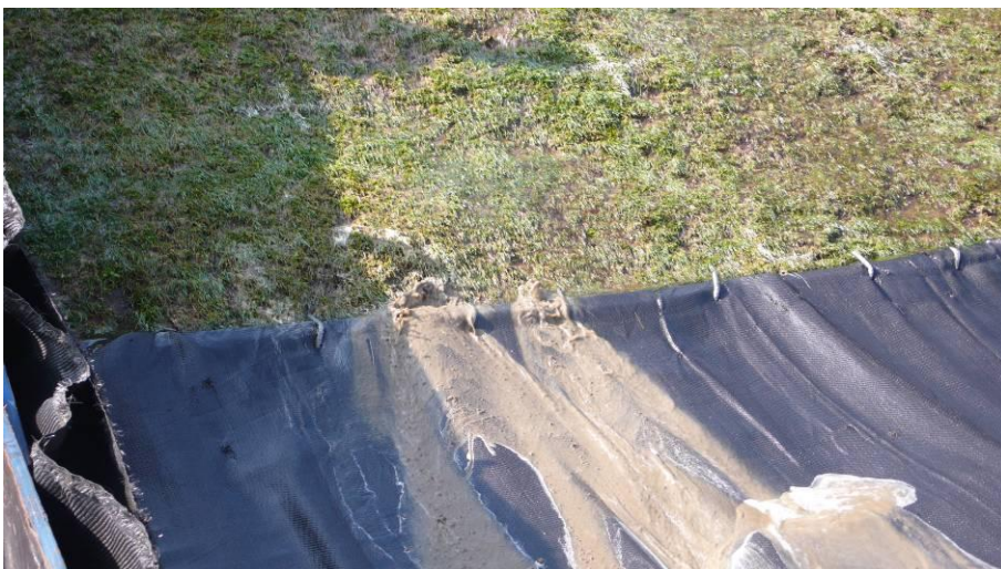
Foto 3.41 Zandmeevoerende wel boven afdekking teen talud
