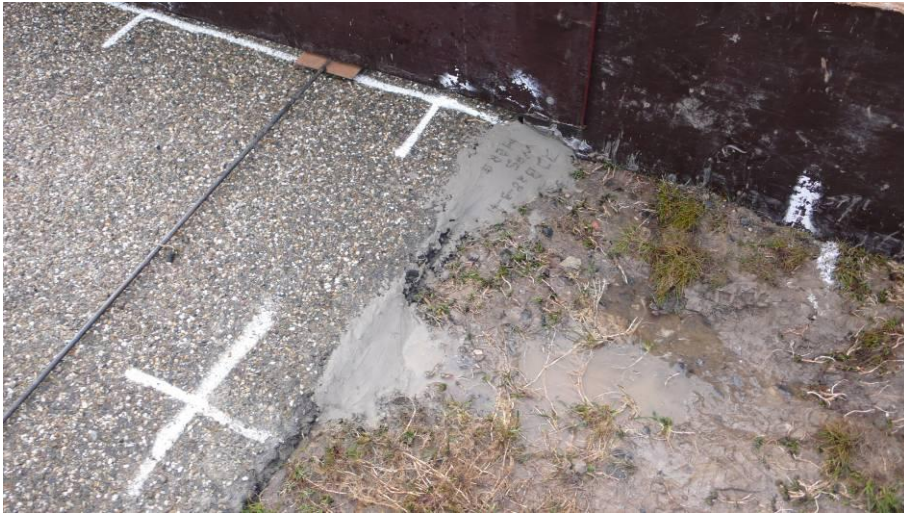
Foto 3.48 Reparatie ondermijning met snelcement
