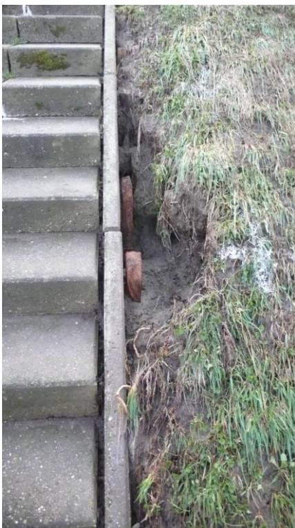
Foto 3.3 Erosie van de kleilaag ter hoogte van vak 11c/12c
