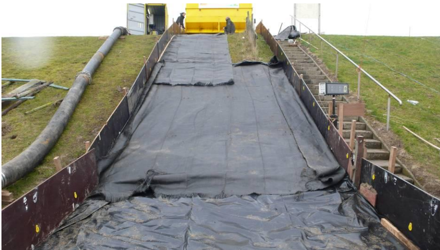
Foto 3.27 Bescherming hersteld talud met geotextiel
