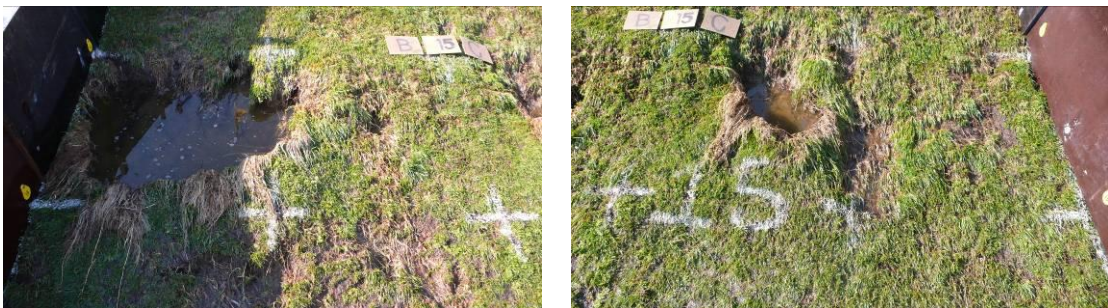
Foto 3.35 Serieuze erosie direct na de teen
