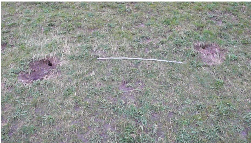
Foto 3.51 Erosie binnentalud ter plaatse van mollengaten
