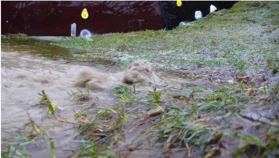
Foto 3.18 Uitspoeling zand ter hoogte van vak 16b
