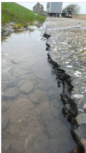
Foto 3.51 Erosie binnentalud ter plaatse van mollengaten
