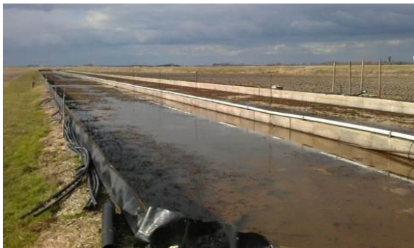
Figuur 4. Kweekbassin bij Wolphaartsdijk (links), waarin een waterdichte vijverfolie is aangebracht (rechts).
