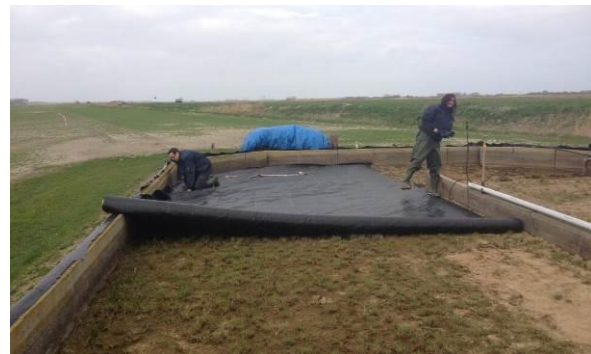
Figuur 4. Kweekbassin bij Wolphaartsdijk (links), waarin een waterdichte vijverfolie is aangebracht (rechts).
