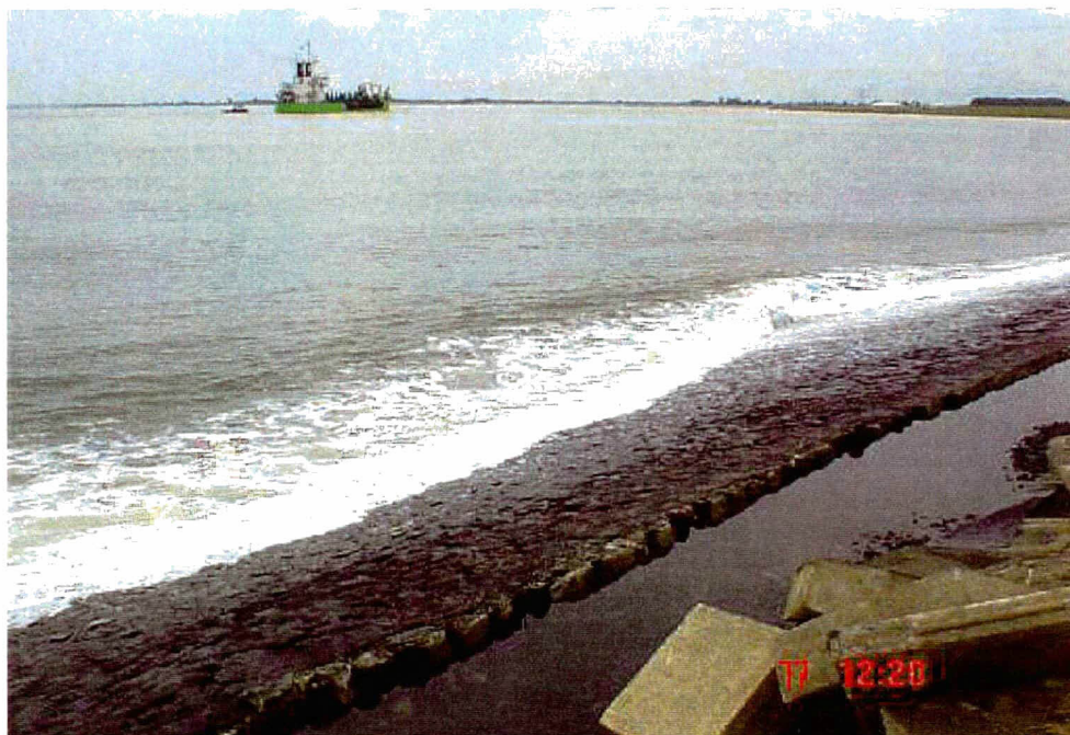
Overzicht meetlocatie, talud belast door golven
