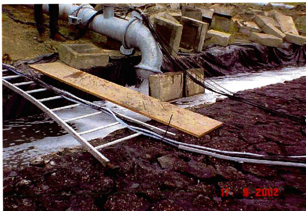
Aanvoer van water in de sloot
