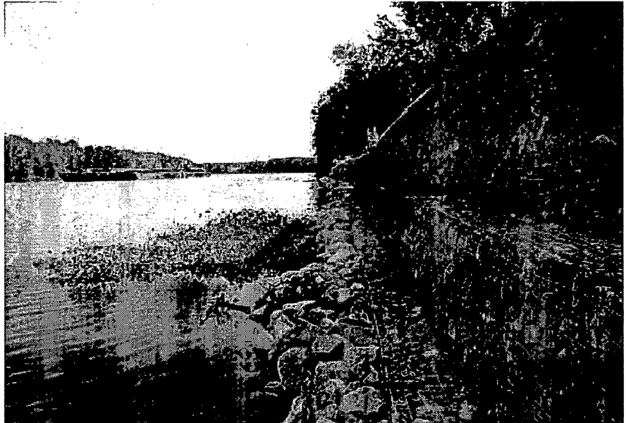
Figuur h: voorbeeld gestapelde gabionconstructie
