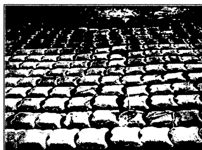
Foto 1, 2 en 3: verzakkingen in hydroblokken tussen dijkpaal 299+50m en 300+50m.
