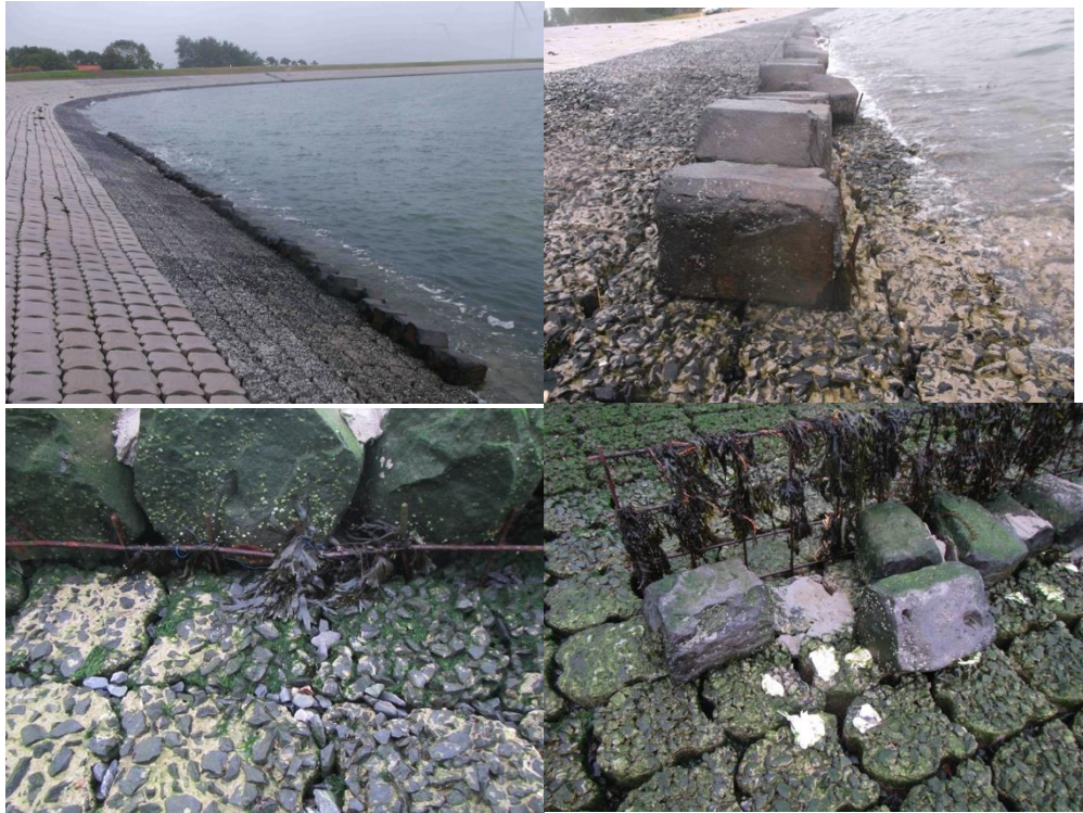
Afbeelding 5. Terugplaatsen van de basaltzuilen en diverse bevestigingsmethoden. Boven links: Overzicht Boven rechts: Kleine stukjes betonijzer ter ondersteuning. Beneden links: Betonijzerlijn; Beneden Rechts: kit (wit), betonspecie (grijs) en betonijzerraster.
