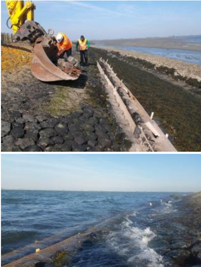
Afbeelding 4. Opslag van de groefwierzulen in vak 2. Boven: werkzaamheden. Beneden: opstelling met hoogwater
