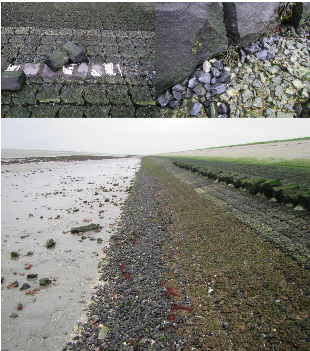
Afb 10. Steenslag en stormschade. Linksboven: Stormschade en losgeraakte basaltzuilen met groefwier. Rechtsboven: Ophopingen van steenslag boven basaltzuilen met groefwier. Onder: Overmaat aan steenslag onder aan de dijkglooing.
