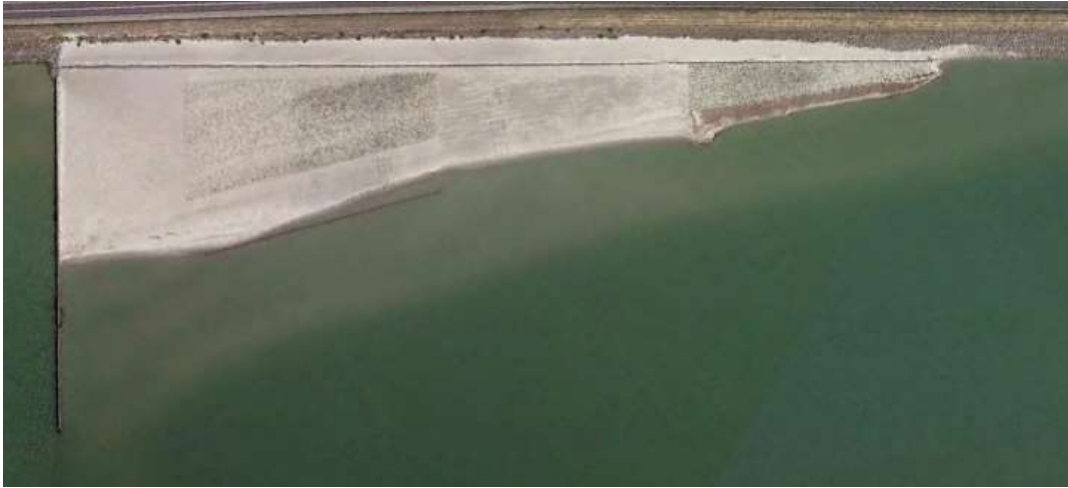
Figuur 1-2 Overzicht proefsectie langs Houtribdijk in juni 2015 na aanbrengen van de vegetatie en een tijdelijke beschermingsdam op het centrale deel van de proefsectie [bron: GoogleEarth-opname 30 juni 2015].
