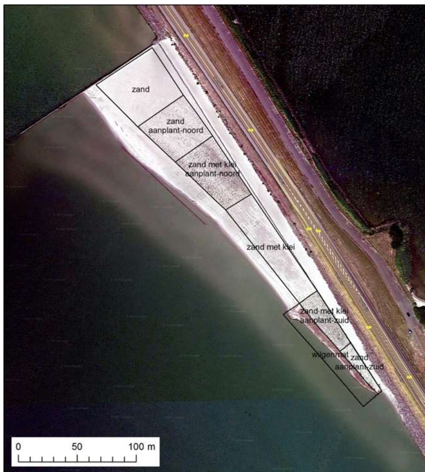
Figuur 8-7 Google Earth opname van de zandige vooroever aan de Houtribdijk op 30 juni 2015 met hierin onderscheiden 6 proefvakken met verschillende aanplantingen en grondsoorten.
