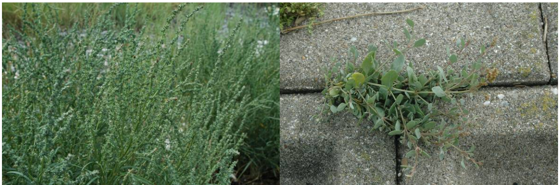
Foto 4.1: Zoutplanten (klein schorrenkruid en gewone zoutmelde) op de steenbekleding van het dijktraject Karelpolder Nieuwlandepolder.
