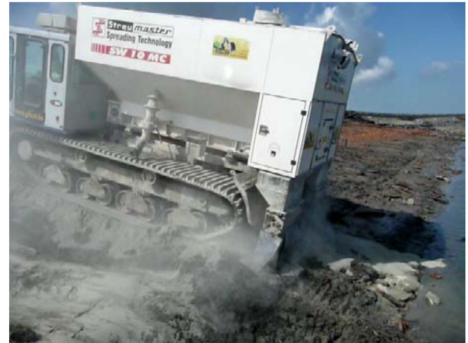
Foto 3: Het uitstrooien van de bindmiddelen op de taludhelling met rupsvoertuigen.
