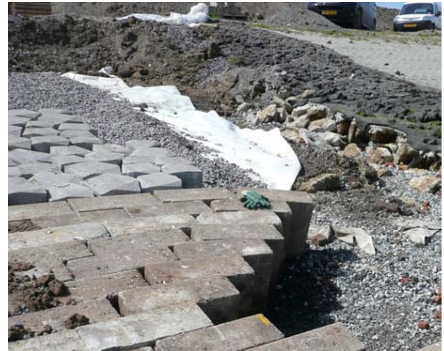
Foto 2 : De zetsteen constructie, de straatlaag, daaronder geotextiel en de Fosforslakken.
