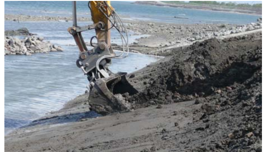
Foto 4 + 5: Het infrezen van de bindmiddelen en het profileren van de helling met de longreach kraan.
