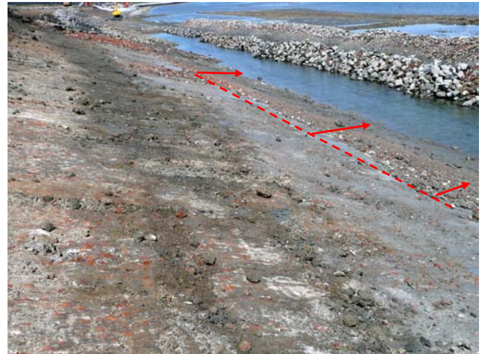
Foto 6: Het gestabiliseerde GeoCrete® talud op de zeedijk, 1 dag na aanleg.
