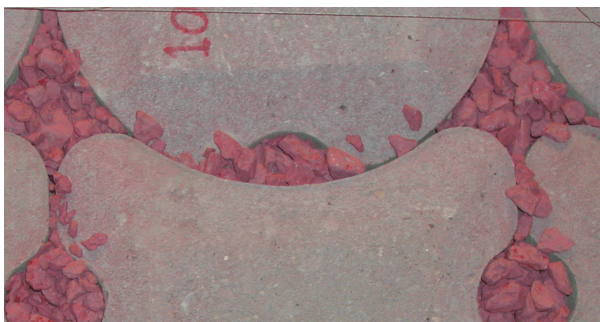
Figuur 3-3: Inwasmateriaal steenslag (5-11): geverfd Noors graniet
