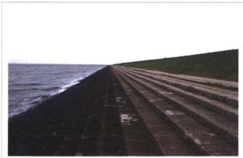
Afbeelding 12 Betonblokken van het systeem Leendertse (cluster Strijenham)
