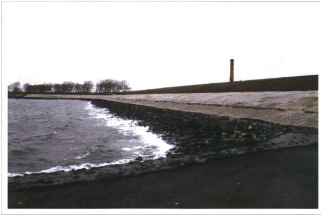
Afbeelding 16 Gebruik van asfalt contrasteert sterk met de beleving van historisch materiaalgebruik, zoals in dit geval de bakstenen schoorsteen van het stoomgemaal Oosterschelde in de buurt van Poortvliet (cluster Strijenham).
