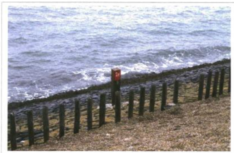
Afbeelding 14 Houten dijkspaal aan de Cauwers Inlaag (cluster Zierikzee)
