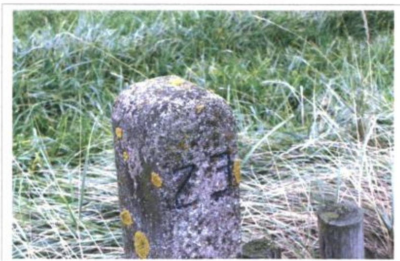
Afbeelding 15 Betonnen dijkspaal aan de Oost-Bevelandpolder (cluster Het Sas)
