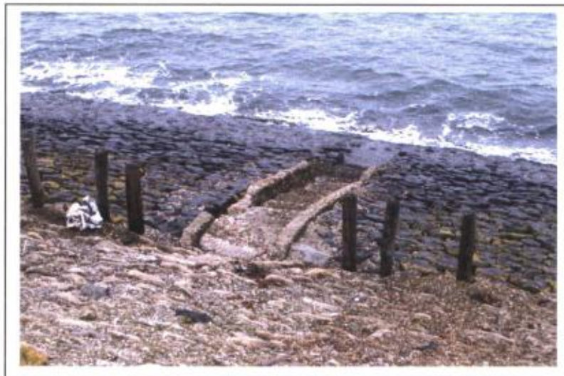
Afbeelding 7 Betonnen trapje voor Inlaag Cauwers (cluster Zierikzee)
