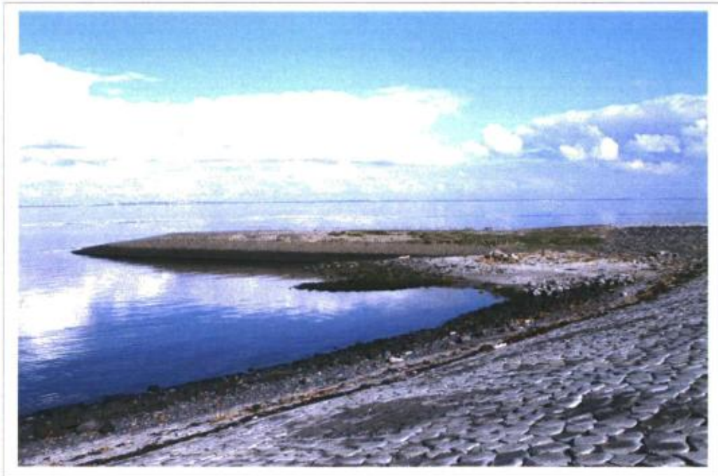
Afbeelding 17 Bij deze nol (Oostnol op Noord-Beveland, cluster Noordkust Noord-Beveland) is de nieuwe glooiing achterlangs getrokken. De natuurlijke materialen en diversiteit in materiaalgebruik (o.a. palenrijen) blijven gewaarborgd.
