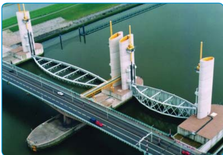
De Maeslantkering en de Hartelkering (samen de Euro-poortkering) beschermen Zuid-Holland tegen stormvloed.
