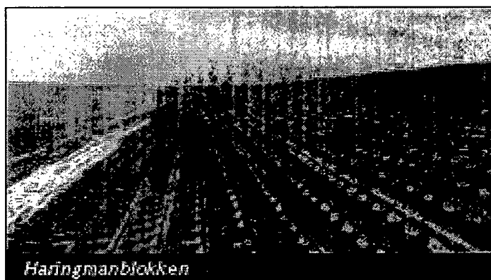
Figuur h: Haringmanblokken uit het dijktraject worden hergebruikt
